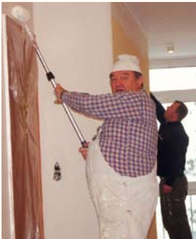
Ehrenamtliche Helfer bei den Renovierungsarbeiten im Gästehaus
